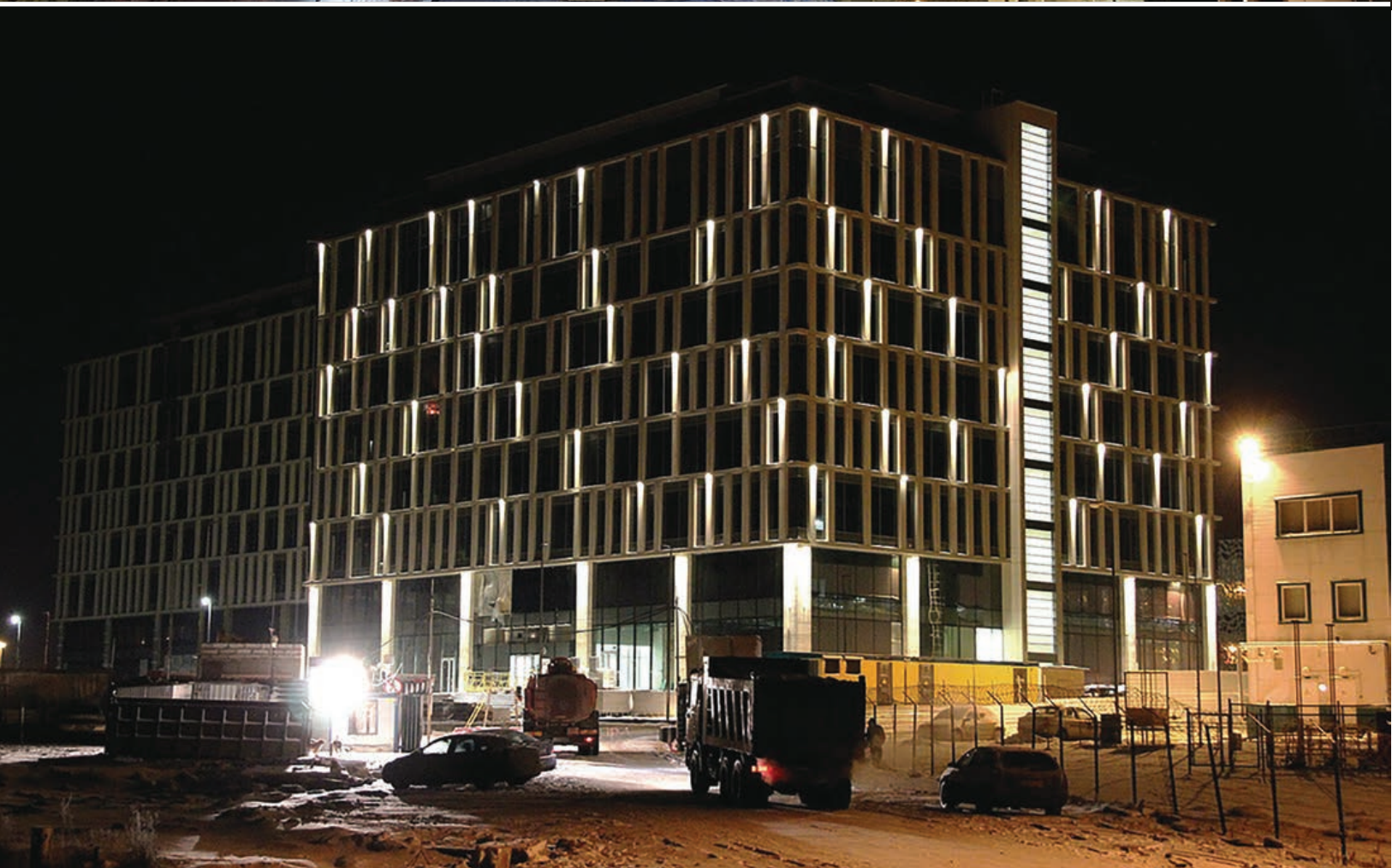
Архитектурно-художественная подсветка фасадов делового квартала NEOPOLIS Новая Москва, Киевское Шоссе
